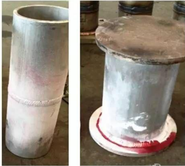
图 3 对接、角接焊缝探伤合格
